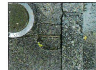
N5 コンクリート杭先(計算点)
